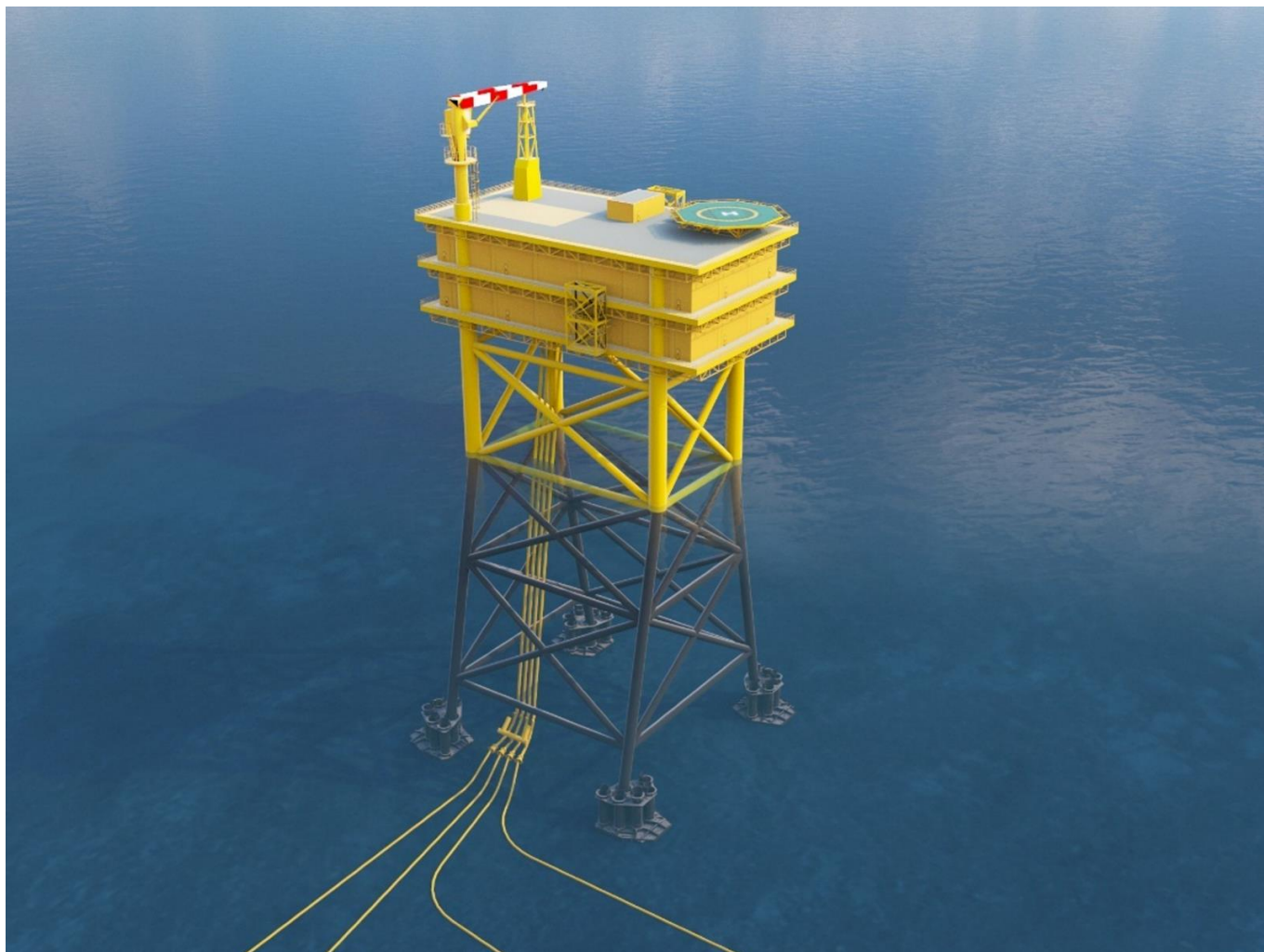
Joonis 6. Avamere alajaama ja selle sõrestikvundamendi illustratsioon
